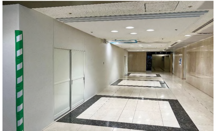
地下1階事務所前廊下
