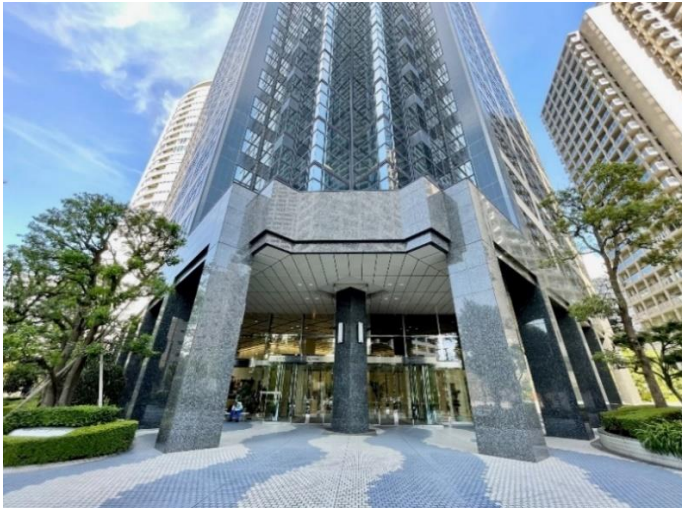
重厚感のあるエントランス外装
