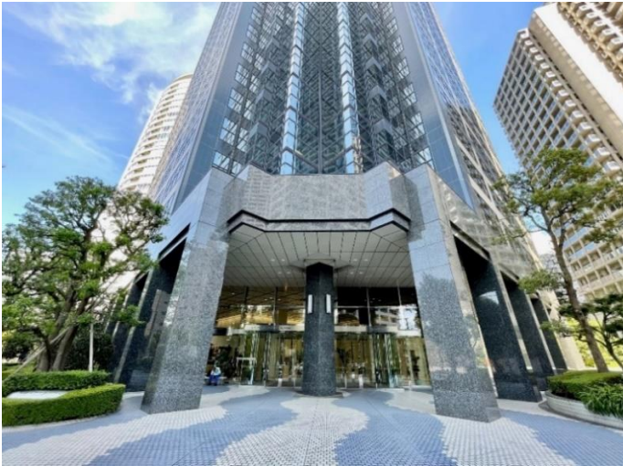
重厚感のあるエントランス外装
