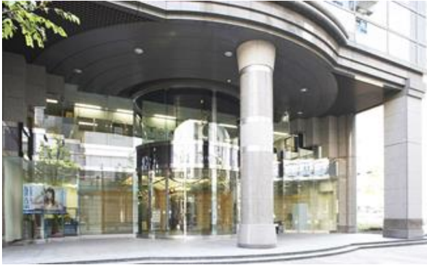
正面エントランス 外観
