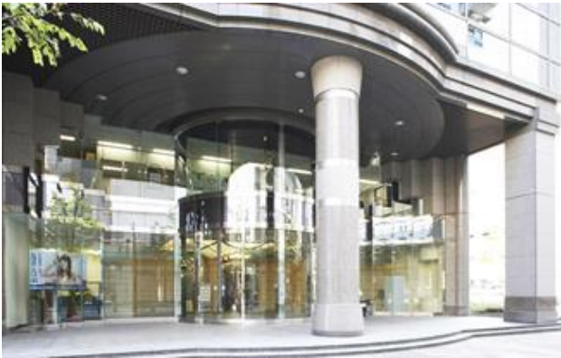
正面エントランス 外観
