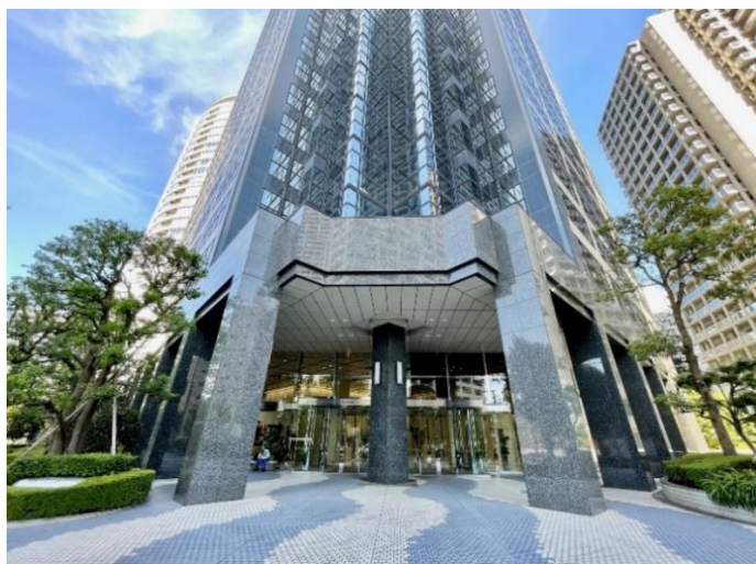
重厚感のあるエントランス外装
