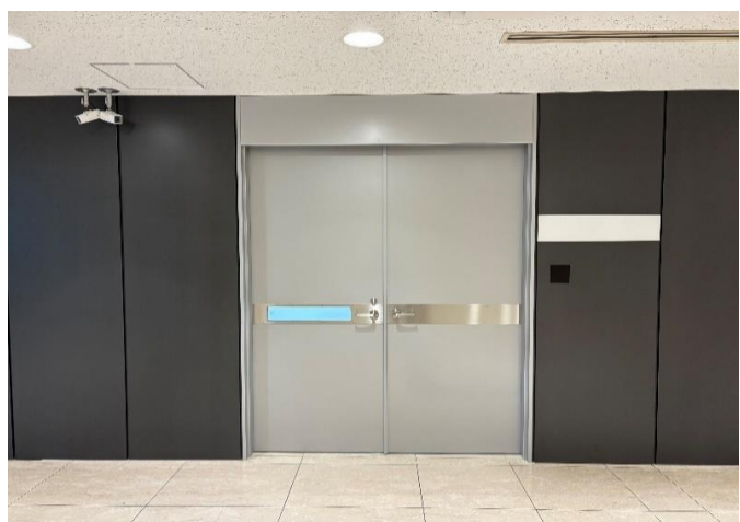
地下1階事務所 廊下側の扉 サンクンガーデン側、水回り側にも扉あり。
