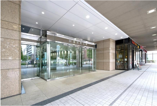
■1階エントランス外部(LED照明設置)
