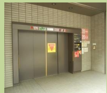
機械式駐車場
