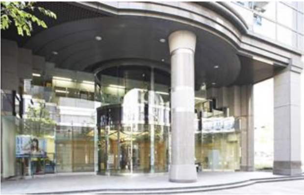
正面エントランス 外観
