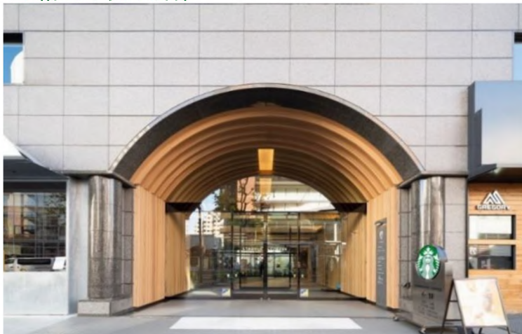
■1階エントランス外部
