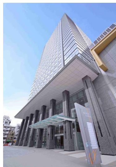
エントランス外観
