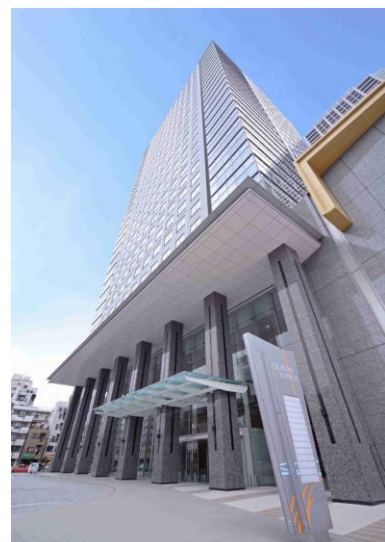
エントランス外観
