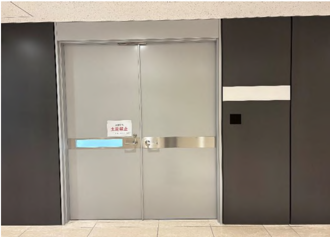
地下1階事務所 廊下側の扉
