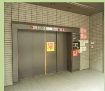
機械式駐車場
