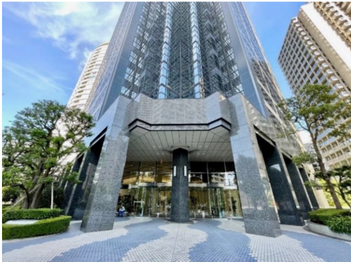
重厚感のあるエントランス外装
